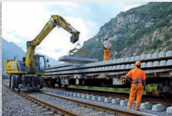
Železničná trať na štrkovom zvršku
