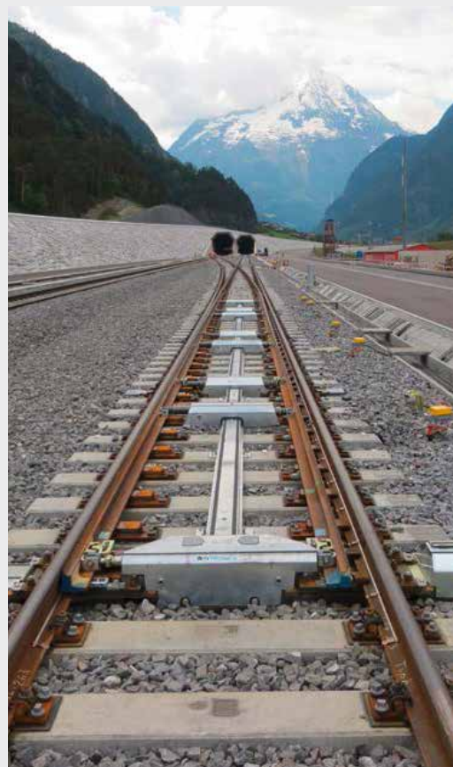
Portálová výhybka tunela
