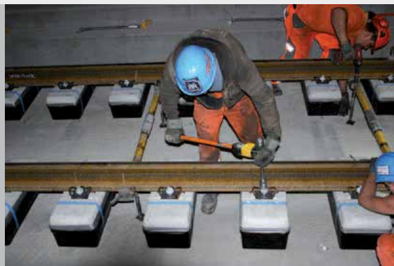
Predmontáž koľajníc s predpripravenými jednoblokovými podvalmi
