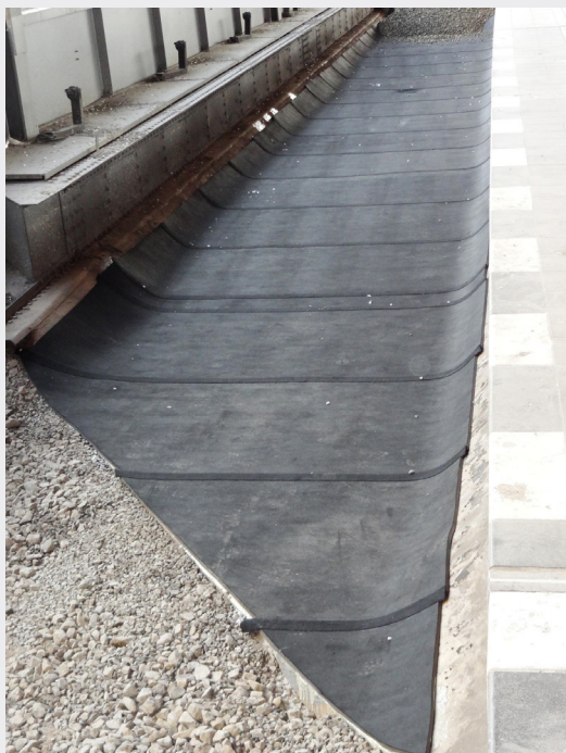
Obr. 4) Pokládka podštrkovej rohože Sylodyn® DN 619
