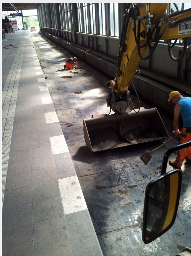
Obr. 3) Bodové poškodenie podštrkovej rohože pri vyberaní štrku
