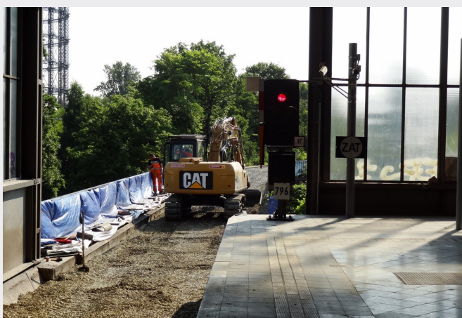
Obr. 2) Vyberanie štrku pomocou ťažkej techniky
