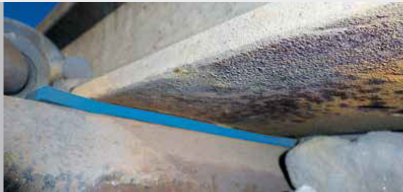
Vlaky na extrémne namáhanej trati sú dlhé približne 2 km Zabudovaná podkoľajnicová podložka
