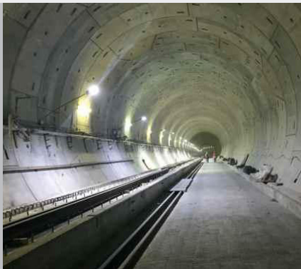
Tunel pripravený na inštaláciu
