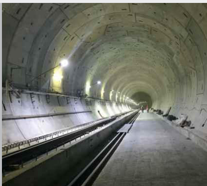
Tunel připraven k instalaci
