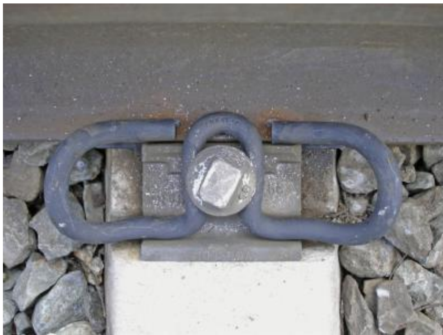
Obrázok 1-2 Pružná zvierka Skl 28 pre oblúky malých polomerov s R < 600 m
