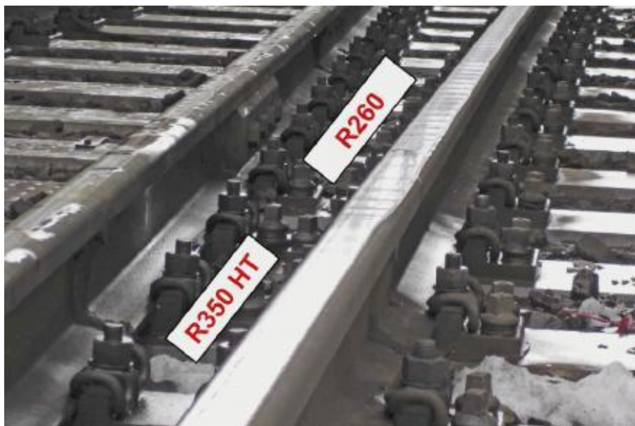
Obrázok 1-6 Tvorba vlnkovitosti na dvoch koľajniciach v oblúku s rôznou tvrdosťou hlavy koľajnice
