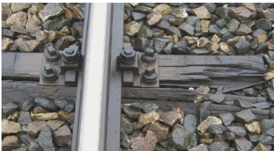
Obrázok 1-3 Drevený podval so známami starnutia
