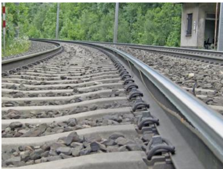
Obrázok 1-1 Oblúk malého polomeru s koľajnicami s tvrdou hlavou, na zníženie bočného opotrebovania a vlnkovitosti
