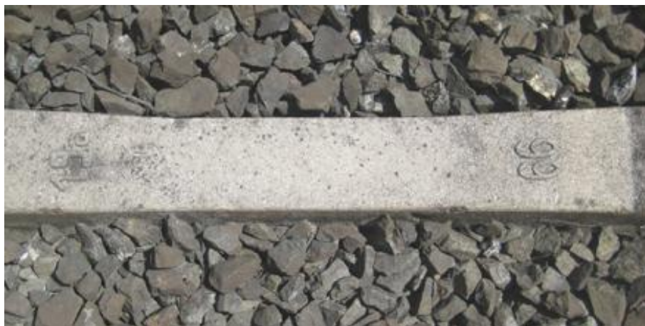
Obrázok 1-16 Betónový podval s podpodvalovou podložkou v koľaji s nízkou kvalitou kameniva
