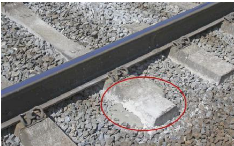
Obrázok 1-9 Koľaj s jemným oderom štrku pod hlavou podvalu
