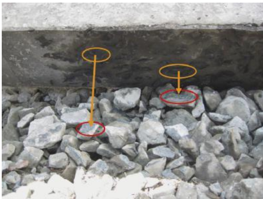
Obrázok 1-15 Ochrana kameniva koľajového lôžka použitím podpodvalových podložiek
