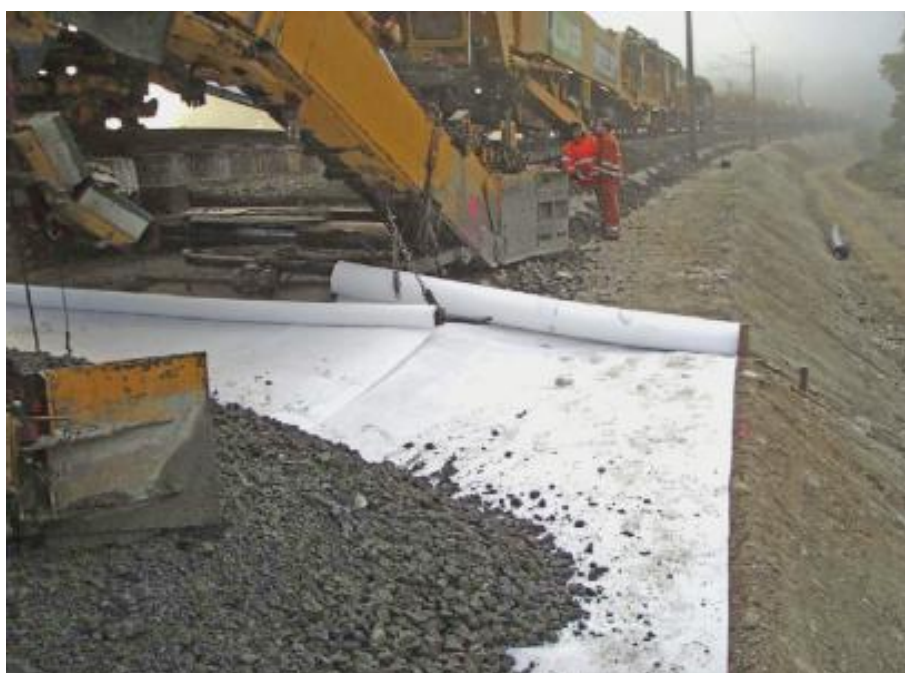
Obrázok 1-5 Mechanizované zabudovanie podkladovej vrstvy s geotextíliou
