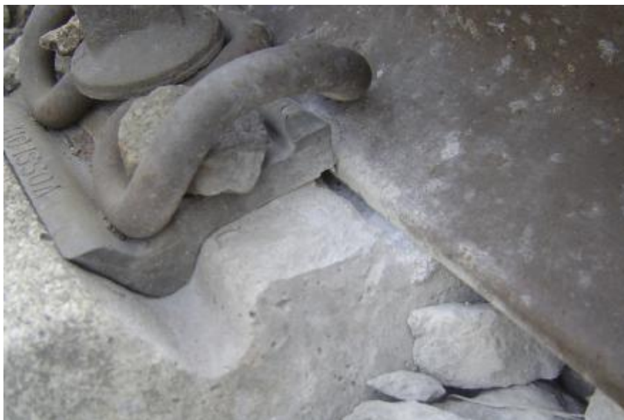
Obrázok 1-8 Betónový podval so zníženou životnosťou v dôsledku oneskorenej výmeny podložky pod päť koľajnice
